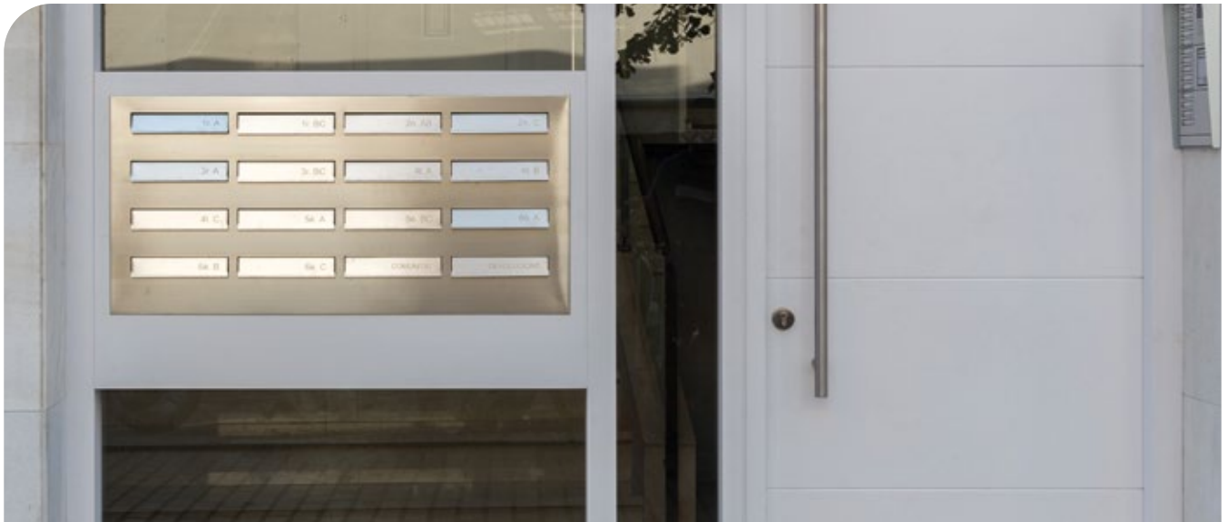
Dettaglio della vista dall'esterno del portale.
